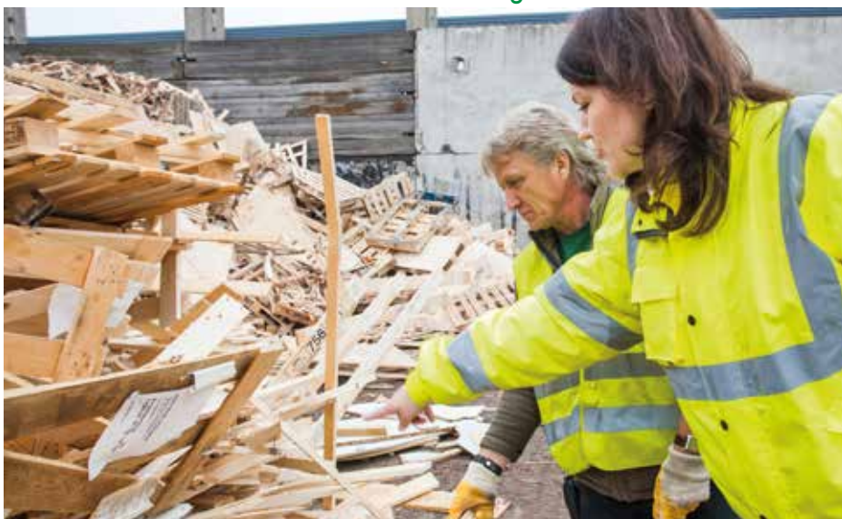
Eine konsequente Abfalltrennung direkt auf der Baustelle für ein höherwertiges Recycling.
